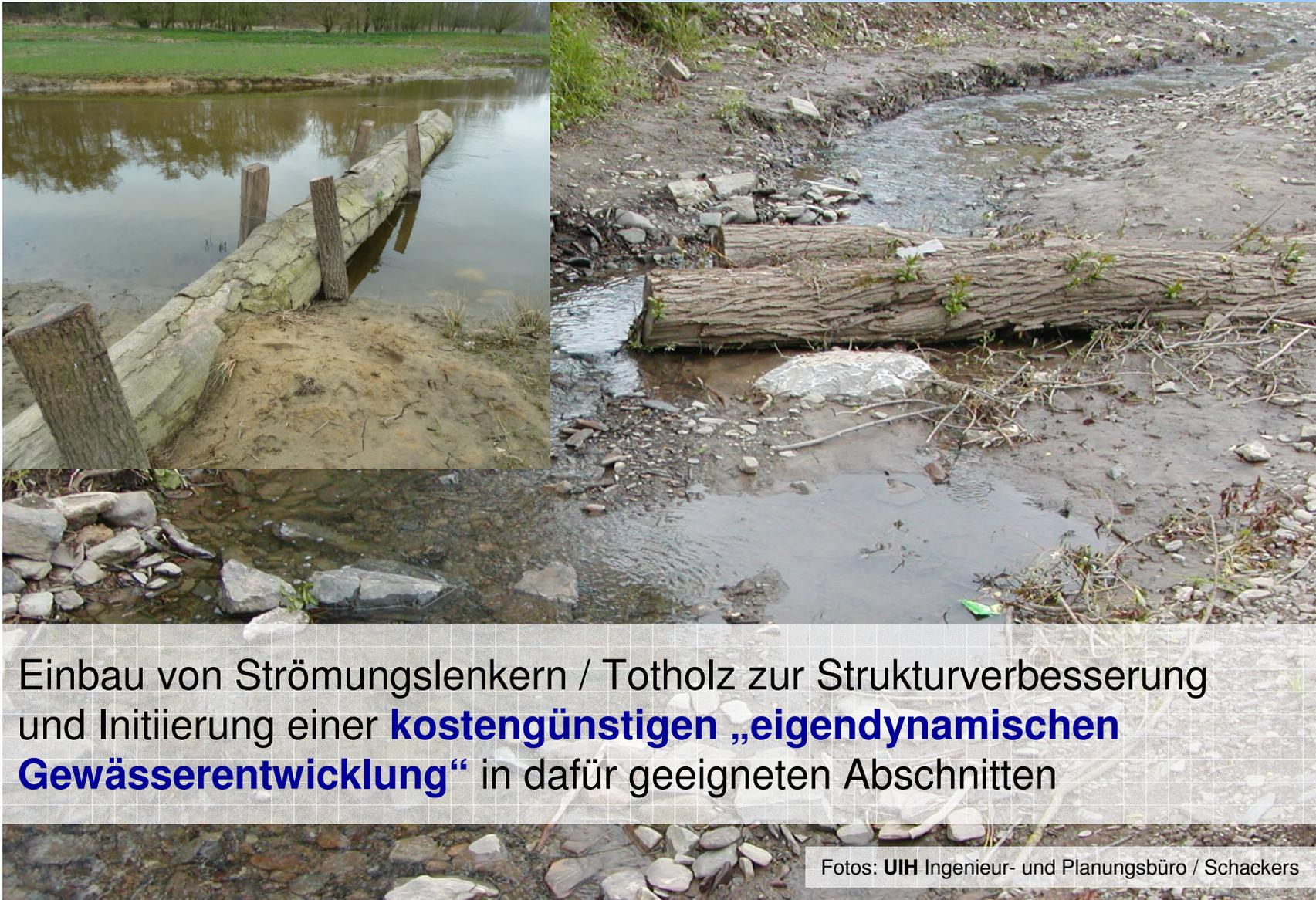
Einbau von Strömungslenkern / Totholz zur Strukturverbesserung und Initiierung einer **kostengünstigen „eigendynamischen Gewässerentwicklung“** in dafür geeigneten Abschnitten
